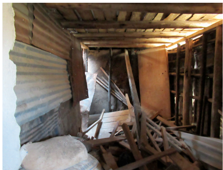
Plek waar de nieuwe wc's moeten komen
